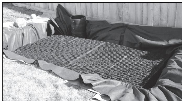
**REMARQUE :** Lors de l'empilement d'AquaBlox<sup>MD</sup>, un seul panneau «A» est nécessaire entre les deux AquaBlox<sup>MD</sup> joints. Voir les instructions d'assemblage du réservoir pour plus de détails.
