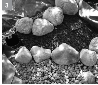
Étape 3 – Remplissez les espaces avec du gravier et formez le contour de roches. Pliez le restant de la toile par-dessus les matrices et recouvrez de roches
